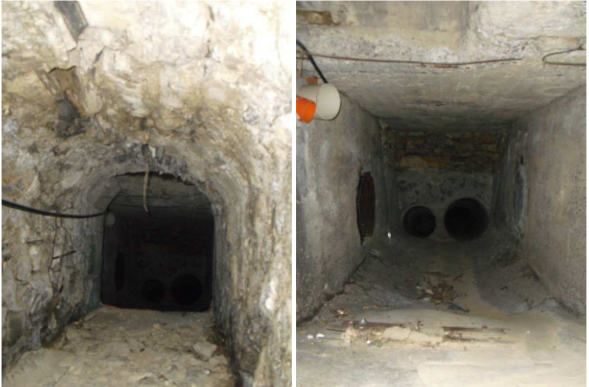
Foto 10 e 11: Cunicolo e camera di confluenza
