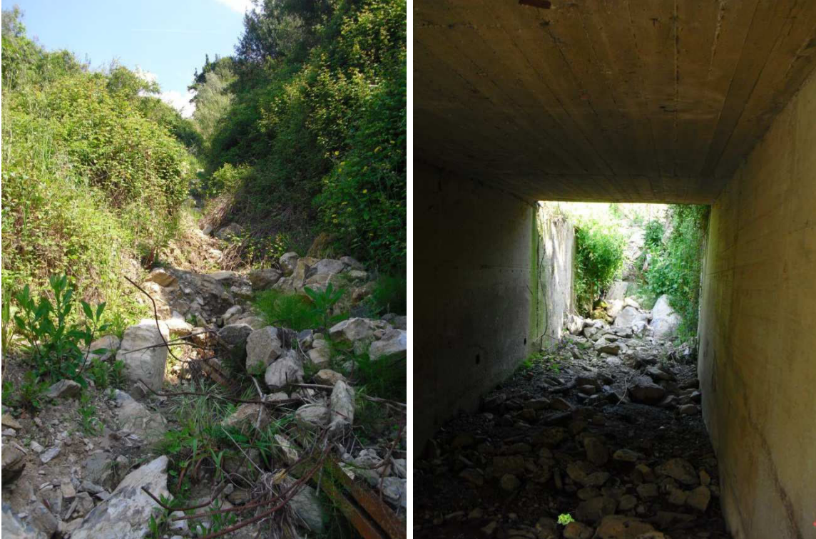
Foto 1 e 2: Alveo naturale e copertura a monte
