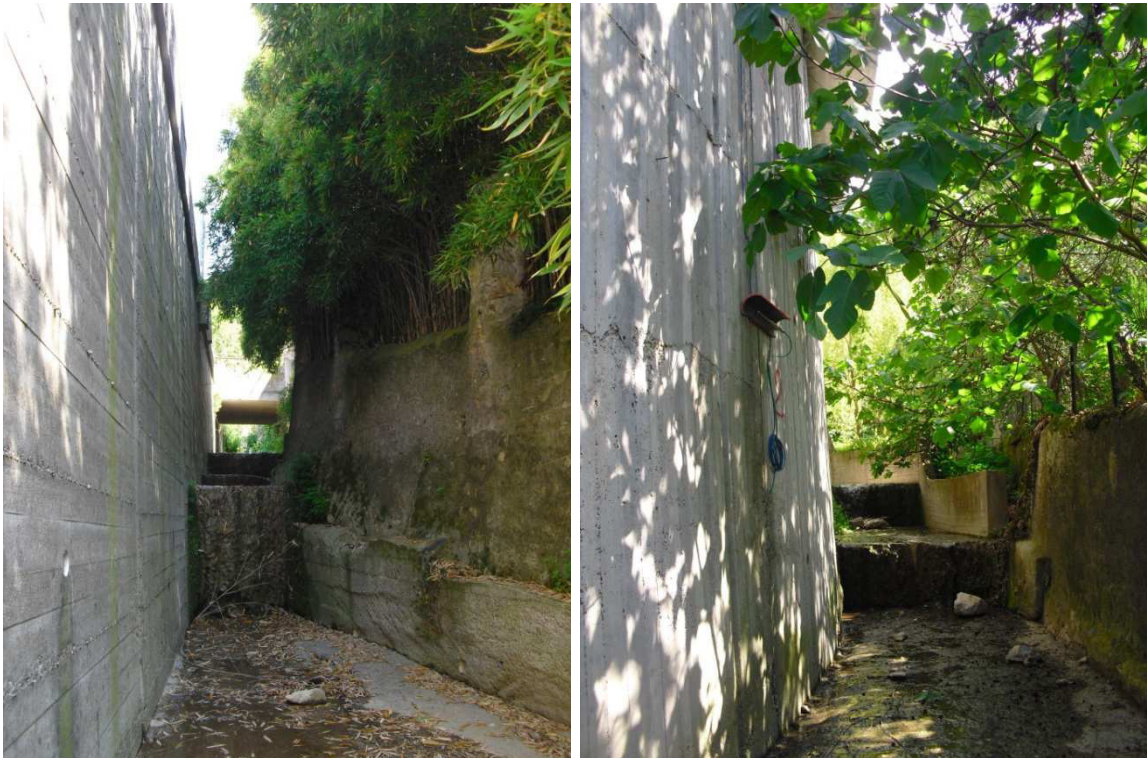
Foto 3 e 4: Alveo in cemento con salti di fondo
