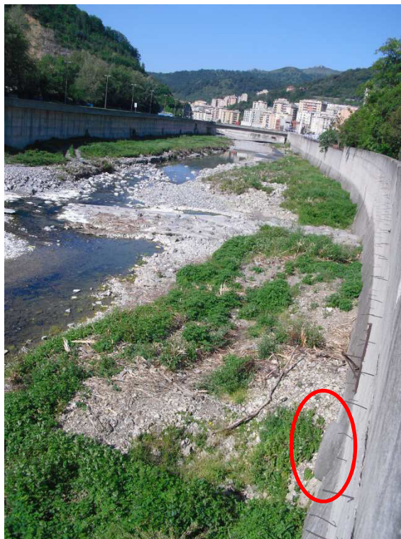
Foto 13: Sbocco nel torrente Bisagno
